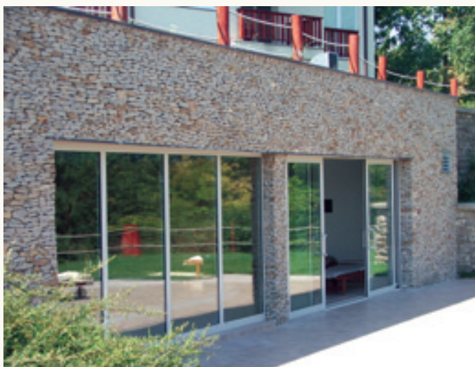
Mediterrán kőburkolat fuga nélkül ú.n. „szárazon rakva”
