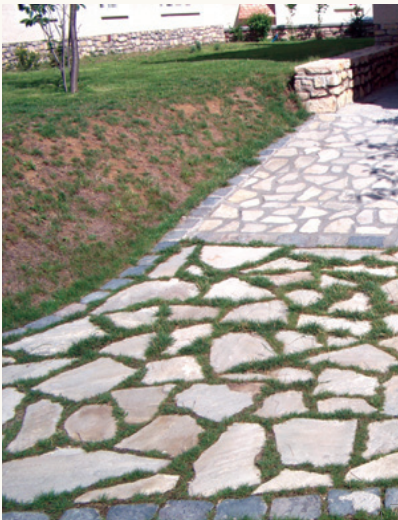
Térburkolat hasított homokkőből betonágyba fektetve
