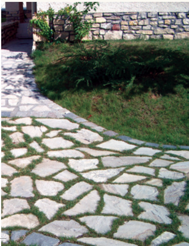
Térburkolat hasított homokkőből kombináltan betonágyba, illetve kavicságyba fektetve
