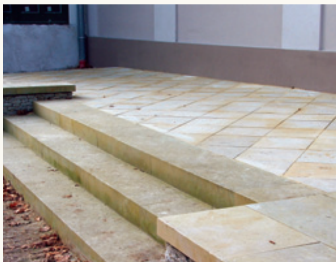
Fűrészelt lap-, illetve tömblépcsők kvarcos homokkőből
