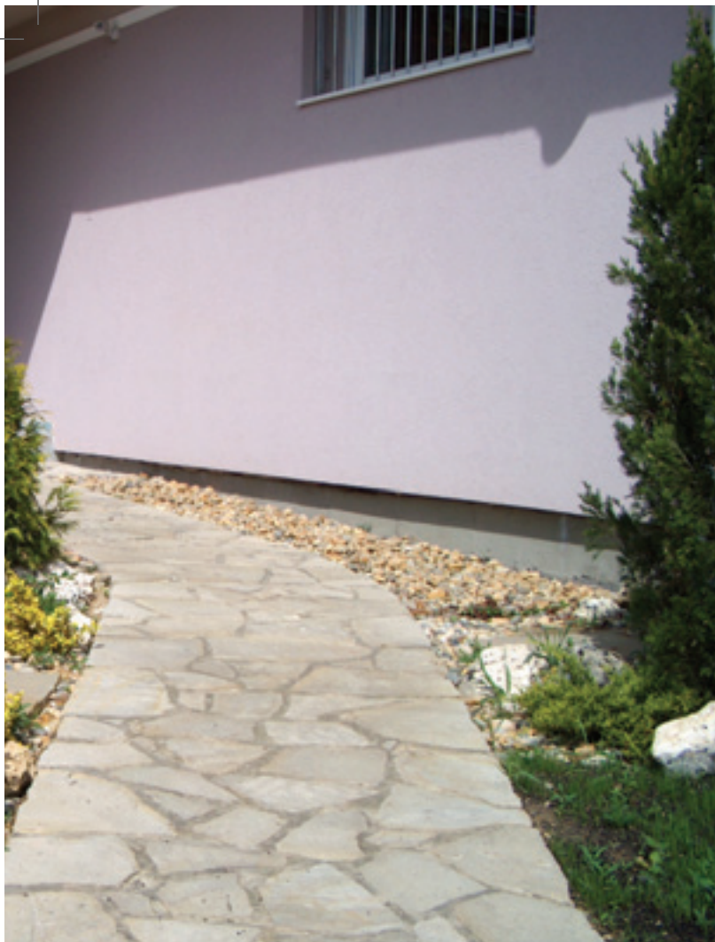
Térburkolat hasított homokkőből kombináltan betonágyba, illetve kavicságyba fektetve
