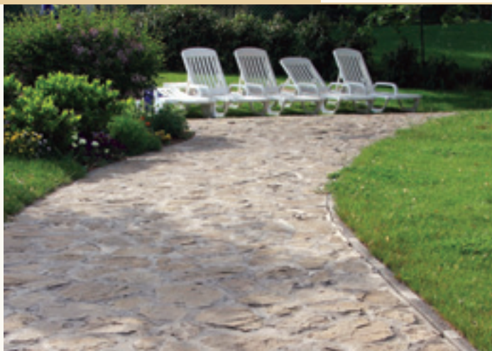
Térburkolat hasított homokkőből betonágyba fektetve
