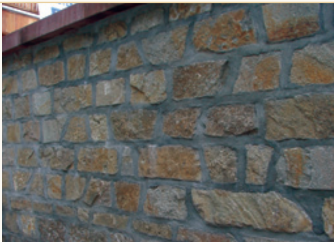
Két oldalt párhuzamosan tört falburkolókö teli fugával
